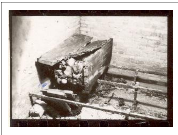
Deksteen met inscriptie. rechtsboven de scheur is een wolfsgat te zien.
