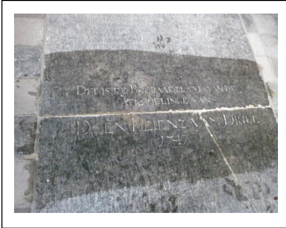
Deksteen met inscriptie. rechtsboven de scheur is een wolfsgat te zien.
